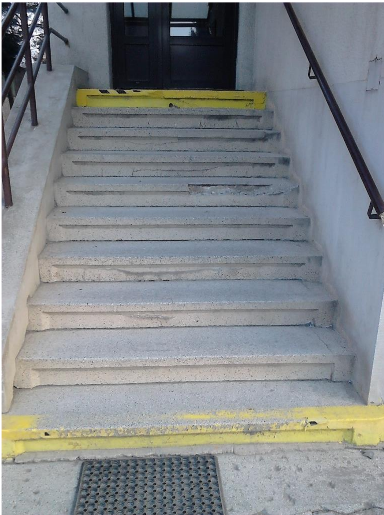
Pohľad zo spodnej časti - schody do budovy Štítnická 12
